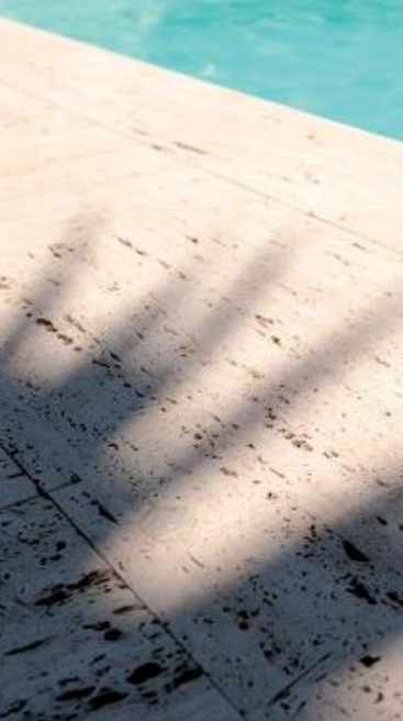
Edles Ensemble rund um diesen Pool: Bodenplatten "Travertin".
